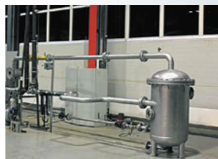
Рис. 13. Стенд для калибровки трехфазных расходомеров и датчиков-регистраторов
