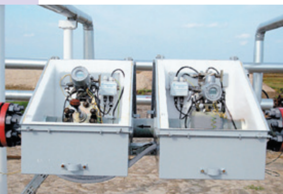
Рис. 11. Двухфазный расходомер «ДФР-01»
